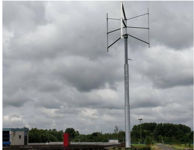
Figure 9 : Exemples d'éoliennes destinées au milieu urbain (Unéole/Fairwind)
