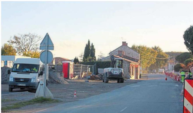
Les travaux de sécurisation seront terminés au premier trimestre 2018.
