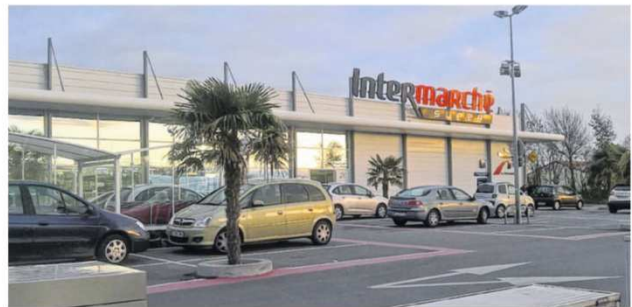
Le gérant travaille sur la construction d'un nouveau magasin dont la surface de vente sera doublée par rapport à celle existante actuellement.
