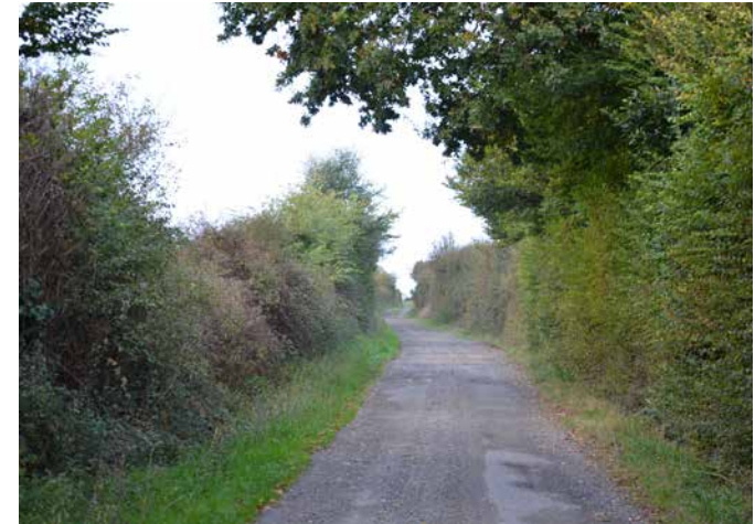
Chemin de la Vierge existant extrait de visite de site 2018
