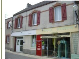
Maison avec magasins en rdc. Façade de l'étage bien conservé : encadrement des fenêtres, bandeau et corniche en brique, volets conservés
