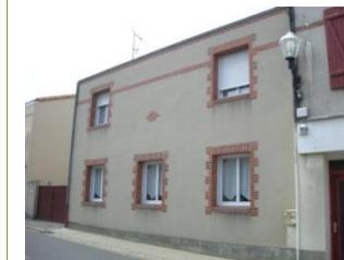
Maison rénovée, encadrement des fenêtres, bandeau, corniche et décoration centrale en brique. Remplacement des volets par des stores
