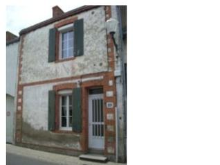
Façade enduit, volet présents, encadrement, bandeau, corniche et chaînage en brique. Fenêtres et portes pvc, stores.
