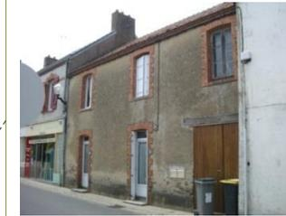
Enduit se décollant par endroits laissant découvrir une construction en pierre. Encadrement des fenêtres et portes et corniche en brique, remplacement des volets par des persiennes. 1 Linteau en bois.
